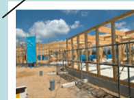
▲現在の工事状況
